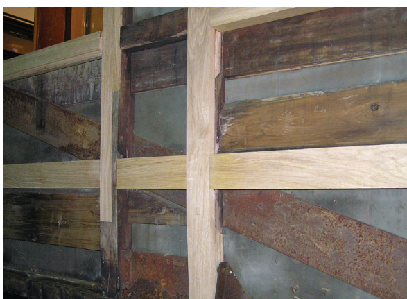
Stommen lagades med ek i samma dimensioner och ytbehandling som den ursprungliga konstruktionen.
