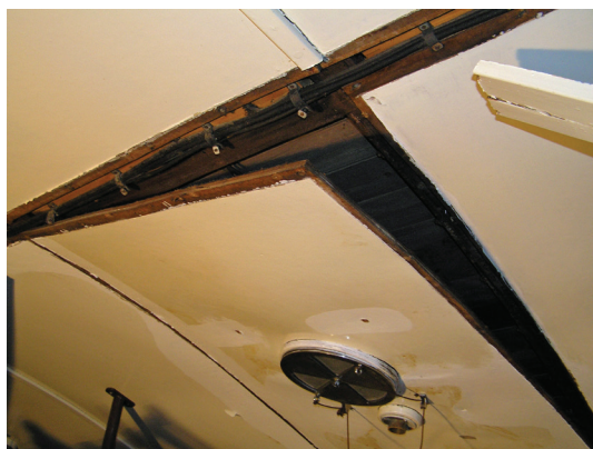
Taket innan restaureringen.
